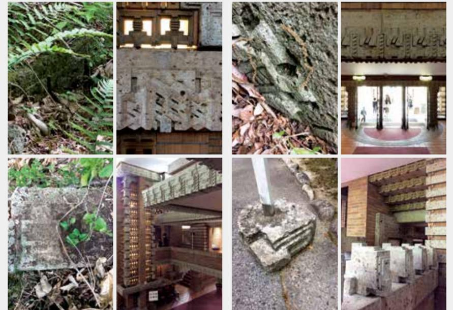
図3 帝国ホテルの大谷石の断片と再建建物の同部位の対照, 明治村
