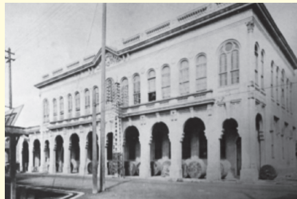
8.電話交換室。《台湾鉄筋コンクリート構造物写真帖》、1913年
