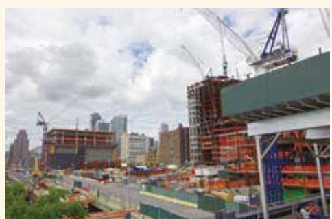
図9 ハドソンヤーズの建設ブーム 撮影/筆者
