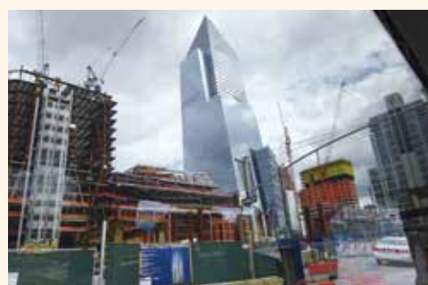
図10 ハドソンヤーズの建設ブーム 撮影/筆者
