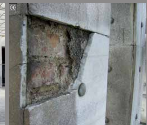
③「郵便貯金局」ホール、柱見上げ ④アムステルダム「証券取引所」ホール・パース H.P.ベルラーへ、コンペ提出案 (大、1885) から実施案 (小、1898) に至る変遷に注目! ⑤「郵便貯金局」ホール、空調吸気口の職人技 ⑥「郵便貯金局」オフィス棟 鉄筋コンクリート床版、テータ ⑦「郵便貯金局」ホール、柱の躯体 ⑧中庭大屋根スケッチ、ホール外屋根の補修不可能 ⑨「郵便貯金局」上部ファサードの大理石版破損例 出典: ③⑤筆者撮影 ④ウィキメディア・コモンズ ⑥BAWAG-PSK銀行、筆者加筆 ⑦⑧⑨HOPPE Architekten
