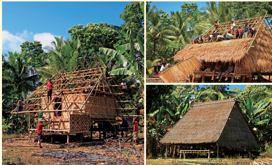
左/インドネシア、アロール島の伝統建築の屋根再建前 右上/再建中 右下/再建後
