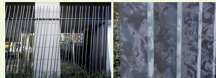
写真・2 ルーバー正面 写真・5 ルーバー近景 (3年8カ月経過時)
