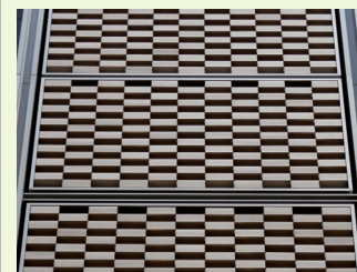
写真・2 テラコッタ調仕上げ粉体塗装の例 (日本橋某所)
