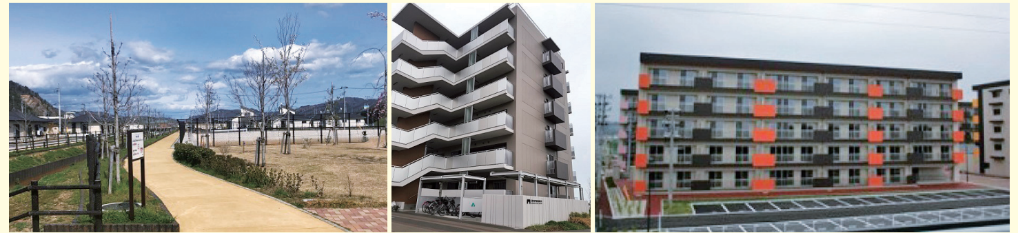
宮城県石巻市の復興事業後の公共施設・公営住宅
