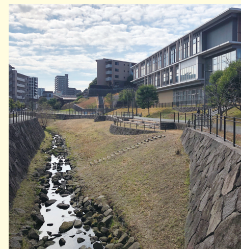
北九州市立八幡西図書館そばのランドスケープ
