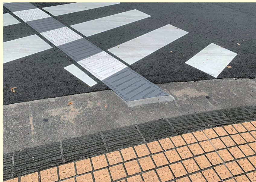
横断歩道にある点字ブロック
