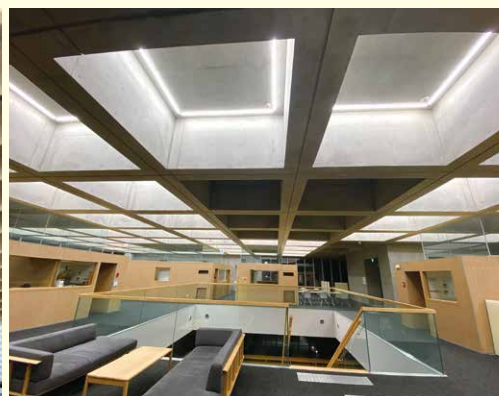
写真7 土木工学棟のワッフルスラブ
