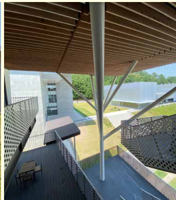
写真4 建築学科棟の樹状柱
